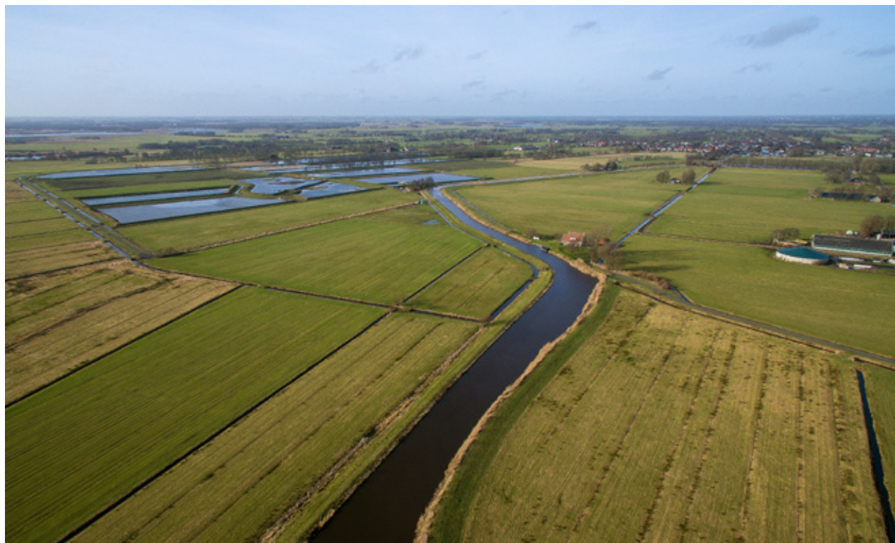
Onder, afbeelding 80 De vaart en ringdijk langs de Oudegaasterzanding. Rechts is ook de rationale blokverkavelingsstructuur te zien. De droogmakerij ligt als een eigen 'wereld' midden in de opstreckende verkavelingsstructuur van het veenweidelandschap. Foto: Fred Kok.
